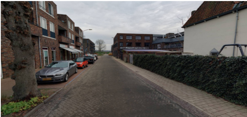
Aanleg riolering en vervangen bestrating Deken van den Ackerhof
