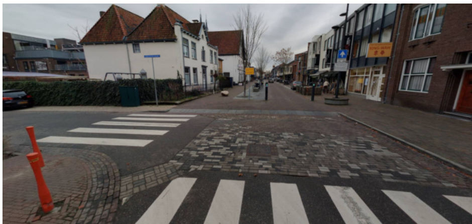
Aansluiting riolering en vervangen noodbestrating splitsing Deken van den Ackerhof - Grotestraat – Vorstendom
